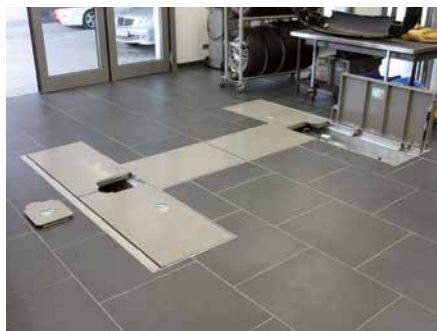
Öffnen und Schließen der Abdeckung wird durch ein pneumatisches Dämpfersystem unterstützt
