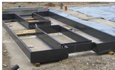
Einbaurahmen für Fahrflächenvarianten mit und ohne Bodenausgleich zum genauen Einpassen der Hebebühne. Durch die vorgefertigten Einfassungsrahmen wird hohe Genauigkeit beim Einbau erreicht.
